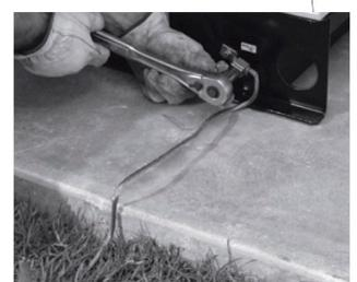
Es obligatorio la instalación del caño flexible provisto con el equipo para absorber las vibraciones y proteger la instalación de gas.
